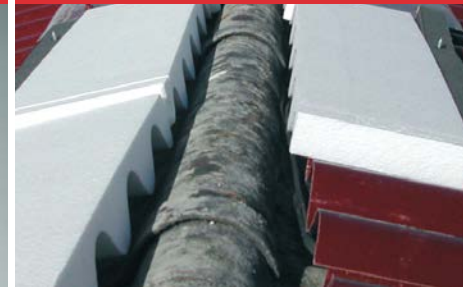
FAÎTAGE - POSE DE LA FAÎTIÈRE DOUBLE
