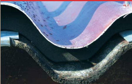
COUVERTURE PLAQUES POLYESTER OPAQUES
